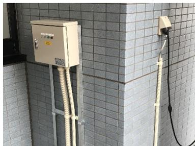
※推奨保護管及び配線（配線は融雪機本体とセットとなっています。長さは標準で機械本体から制御盤までおよそ 8m 届きます。）
